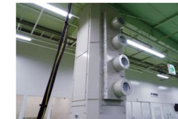
納入機器：標準風量(柱設置型)
